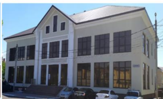
Новое здание по адресу: п. Пригородный, ул. Центральная, 3Д
