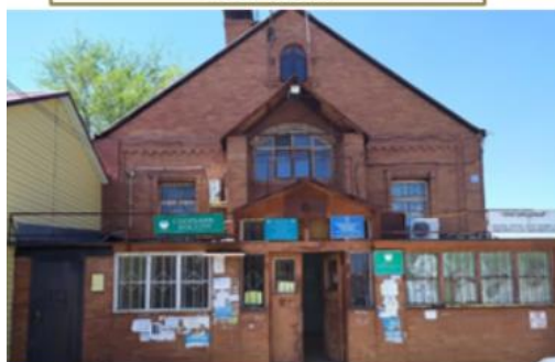
Здание, признанное аварийным, подлежит реализации в 2021 году
