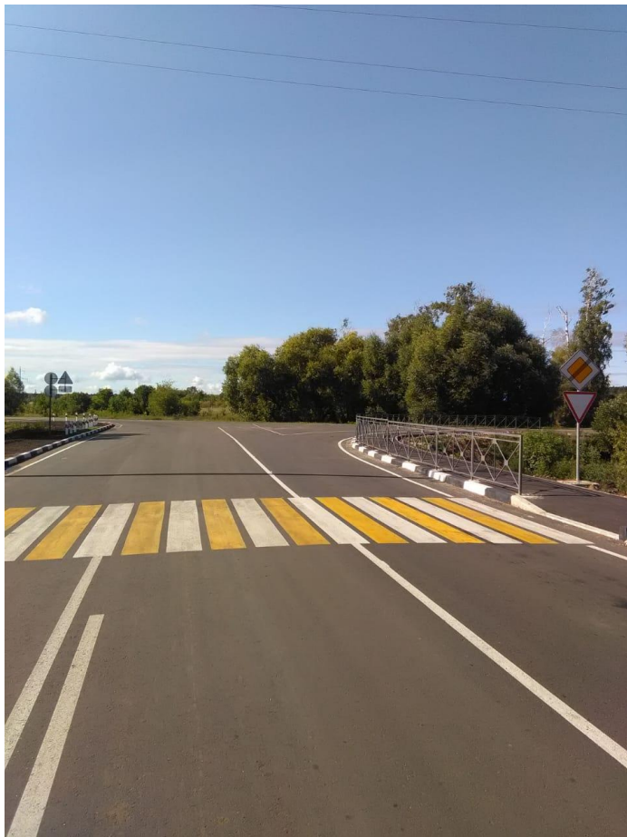
Кап.ремонт Красноармейский- Мордовский Карай-Алексеевский- Памятка
